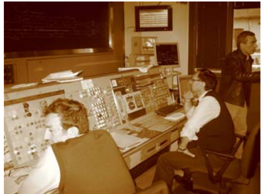
Stazione di Monza, sala comandi, 2008 Monza station, signal box, the inside, 2008
